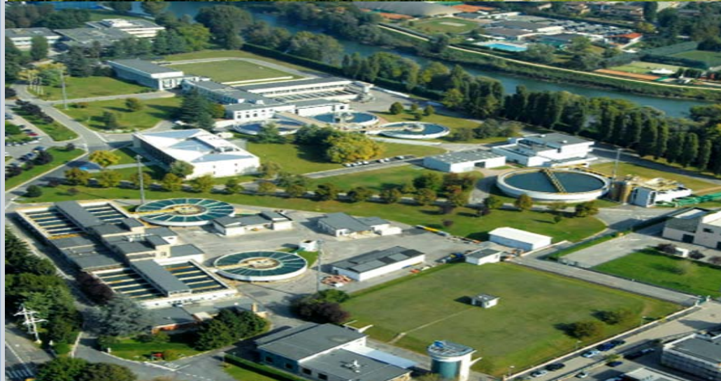
Veduta aerea degli impianti di potabilizzazione del Po
